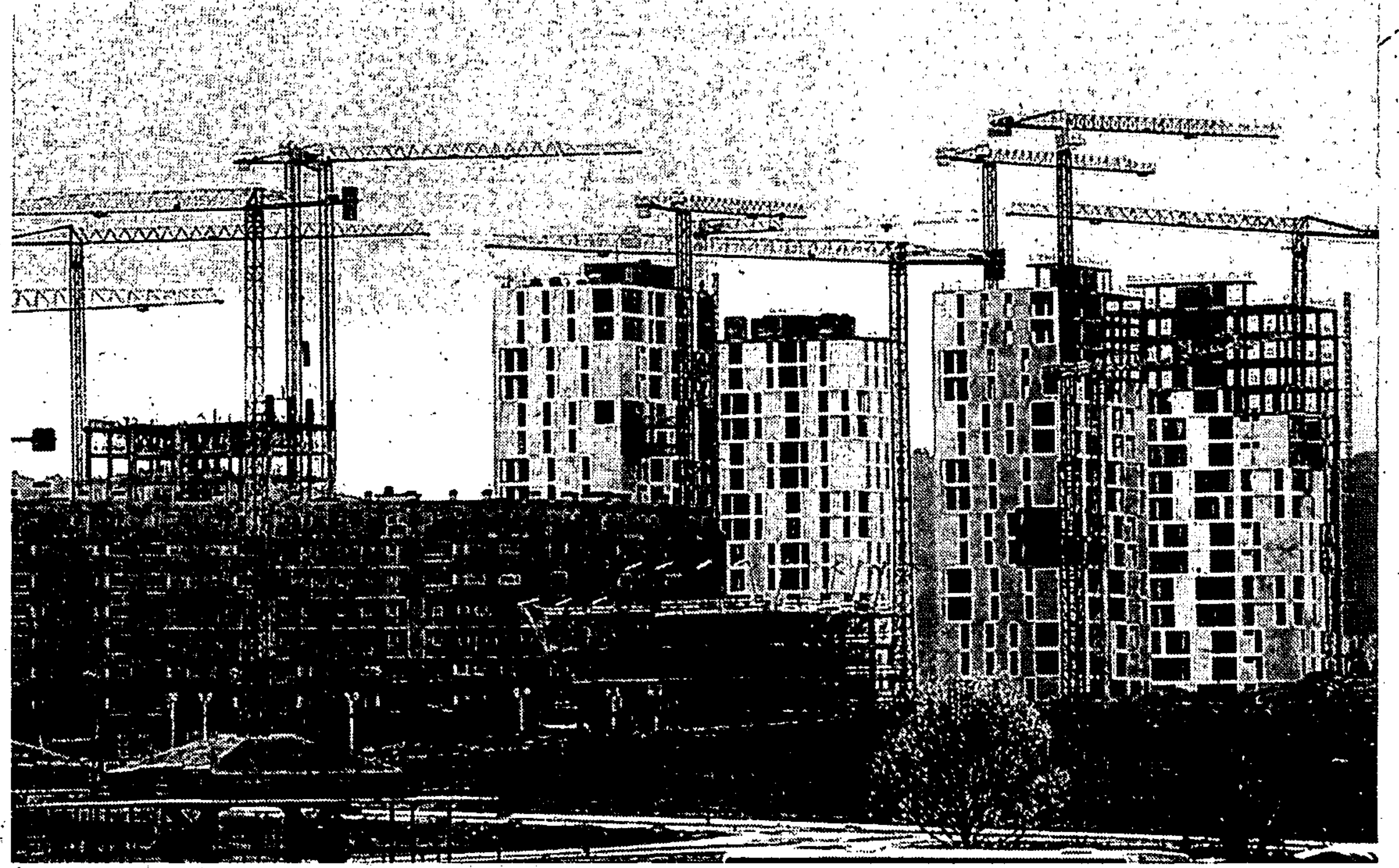
Viviendas en construcción en una zona de expansión urbanística. FOTO: EFE
